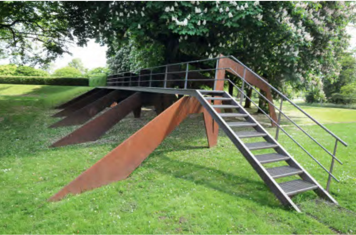
| Op basis van het idee voor de stadswalzone ontwierp MTD in samenwerking met Van Roosmalen Van Gessel het plan voor herstel van de gracht in het zuidwesten bij Bastion Baselaar, inclusief een ondergrondse parkeergarage. | Om de bomen te sparen is de loop van de aarden wal op het Bastion Sint Anthonie gereconstrueerd met cortenstalen profielen.
