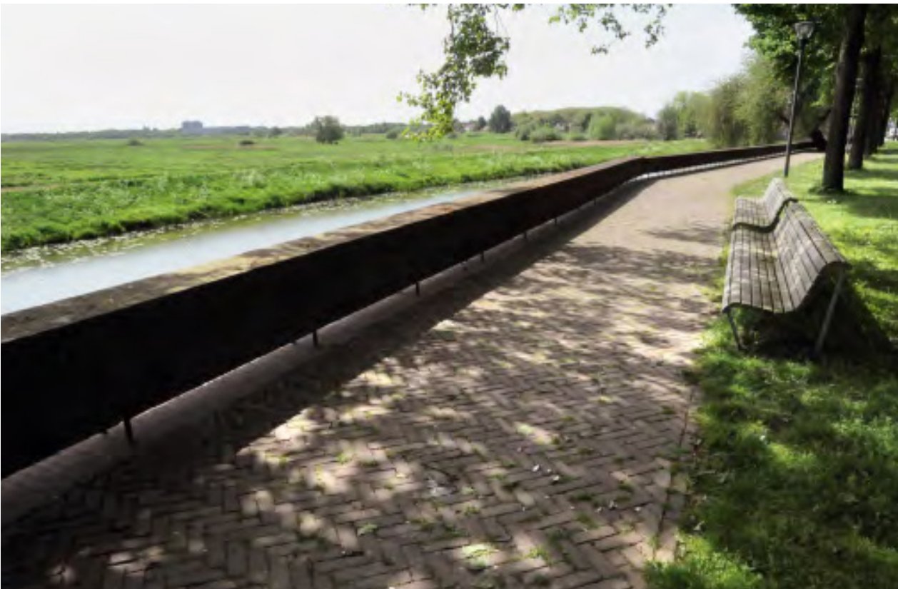
| De stadskant van de vesting wordt steniger van karakter. | Boomrooster met naamsvermelding in de Parklaan. | De zwevende borstwering langs de Parklaan.
